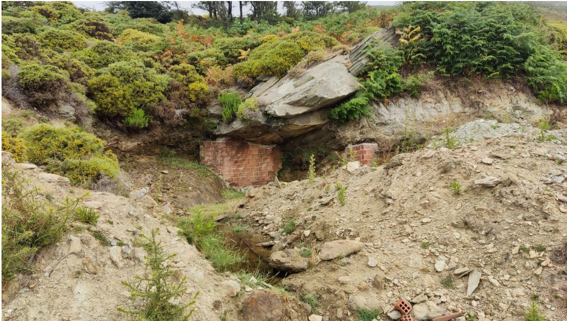
Σημείο 1: Πηγή με υδρομάστευση. Φρεάτιο από άνω πηγή. (22.6.2024)
